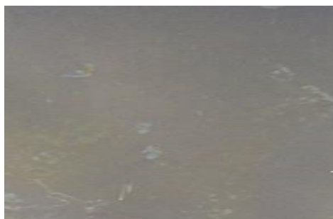
変色防止剤無処理 SST3 時間後の Ni めっき鋼板の外観 変色・発錆あり
